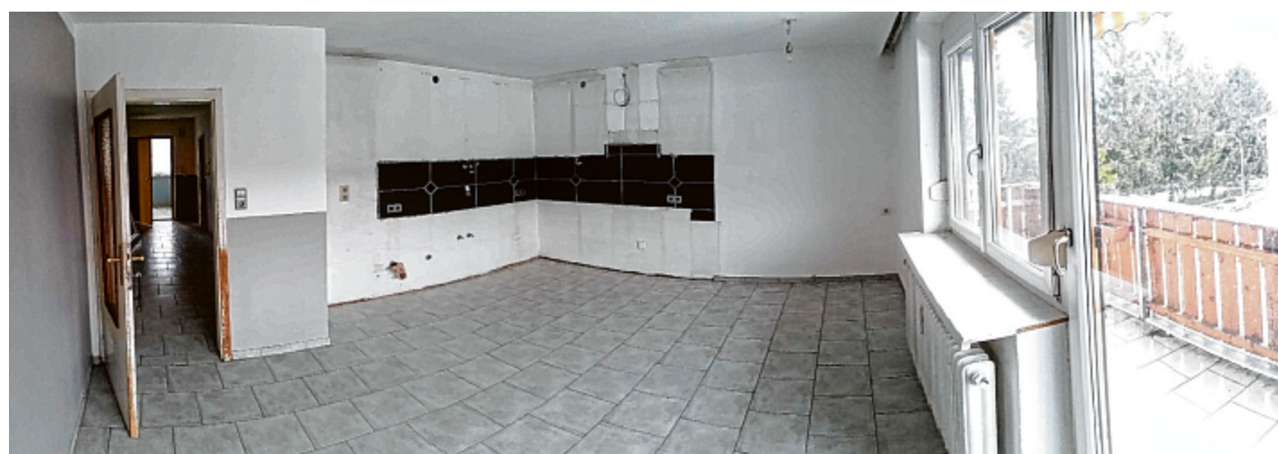
Von der ehemaligen Küche und dem Balkon blieb nicht mehr viel übrig. Der Wohnraum wurde geöffnet, der Balkon erneuert.
