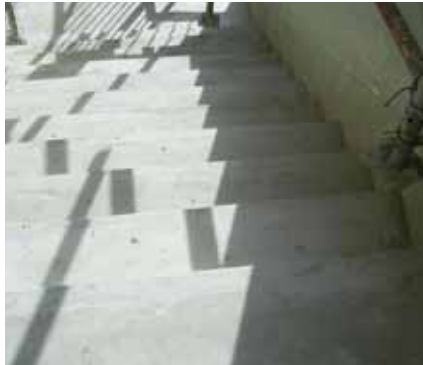
... und nach erfolgter Untergrundvorbereitung (Anschleifen des Betonuntergrundes).
