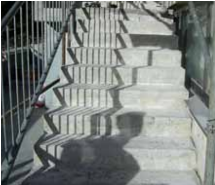
Die Außenstiege am Wipptalcenter nach der Entfernung des alten Fliesenbelags...
