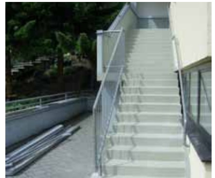
Die fertige Treppe ist rutschfest und langzeitsicher gegen Witterungseinflüsse gerüstet.
