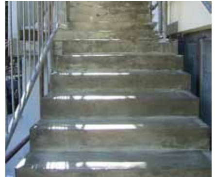
Nachdem die Außenstiege mit Triflex Ceryl Primer 276 grundiert worden ist...
