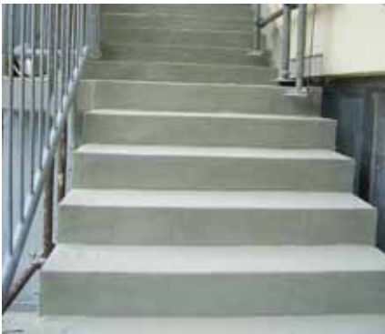
... wurde die Flächenbeschichtung Triflex ProFloor aufgetragen.
